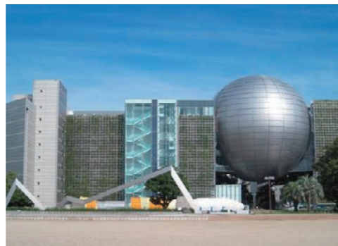
⑧ 名古屋市科学館(愛知県) 地下ピット B-2 工法
