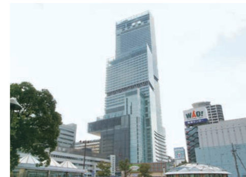
⑪ あべのハルカス(大阪府) 地下外壁、OA フロア他 B-1、Q 工法
