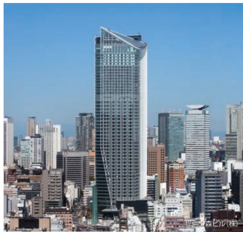
⑤ 虎ノ門ヒルズ(東京都) 外部階段、地下内壁、地下ピット A-1、B-2 工法
