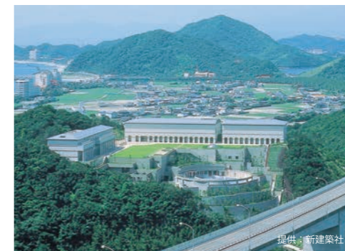
⑬ 大塚国際美術館(徳島県) 消火水槽、中水処理槽、浄化槽 B-2 工法
