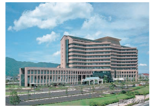
⑭ 島根県立中央病院(島根県) バルコニー、外壁、ヘリポート、ピット、機械室 A-2、A-1、B-2、Q 工法
