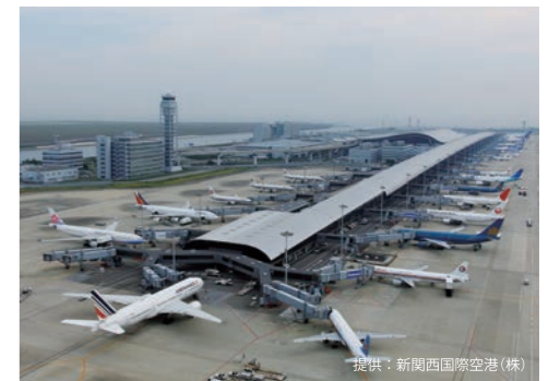
⑫ 関西国際空港(大阪府) 共同溝、他 B-1 工法
