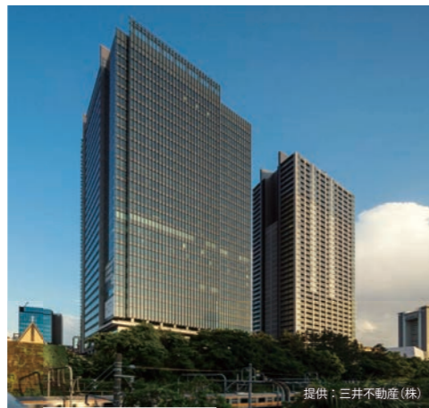
⑥ 飯田橋グラン・ブルーム(東京都) 地下ピット B-2、B-6D 工法
