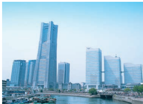
⑦ MM21 地区(神奈川県) 各種水槽、室内、フリーアクセスフロア、他 B-2、B-4、A-1、Q 工法
