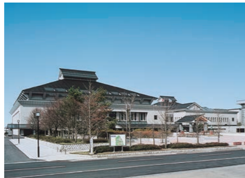
④ 青森県立武道館(青森県) 地下外壁、相撲場床 B-2、C-1 工法
